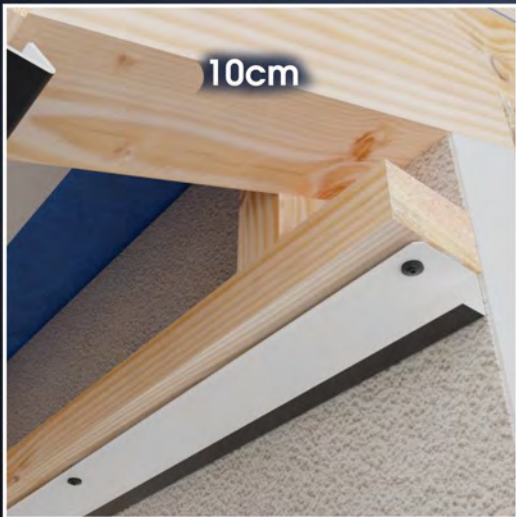
Montarea suportului pe cadrul de lemn. Recomandam montarea cu ajutorul hol-suruburilor pentru țiglă metalică.
