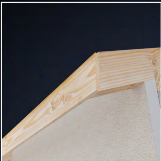
Pregătirea acoperișului pentru asamblarea sistemului de drenaj.
